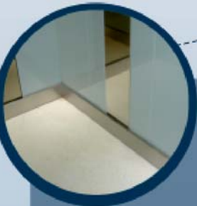
Paviment antilliscant i sòcol en Inox
